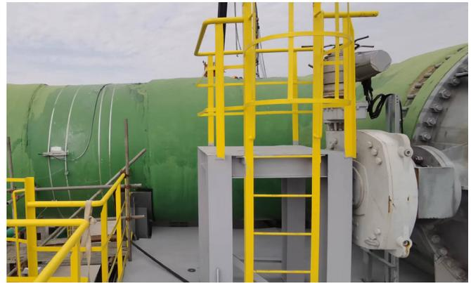
Installation von Clamp-On Durchflussmessgerät auf großer GFK-Leitung mit reduzierten Ein- und Auslaufstrecken
