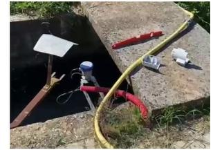
Installation von OPTIWAVE 1540 über Bewässerungskanal
