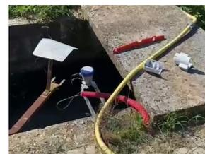
Installation d'OPTIWAVE 1540 au-dessus du canal d'irrigation
