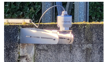
Installation von OPTIWAVE 1540 über die mitgelieferte Halterung
