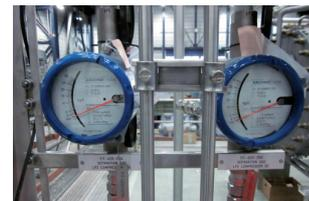
Schwebekörper-Durchflussmessgeräte an Gastafel montiert
