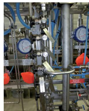
Durchflussmessung von Stickstoff mit dem H250 M40
