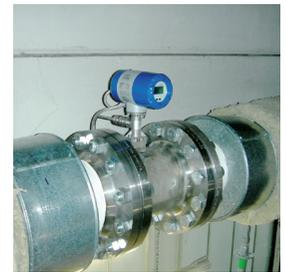
L'OPTISWIRL 4070 DN 200 à un point de mesure directement en aval d'un générateur de vapeur
