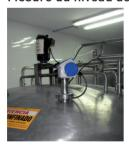
Le volume contenu dans le réservoir est mesuré en continu et affiché (en temps réel) par l'OPTIWAVE 7300 C. Le transmetteur de niveau radar OPTIWAVE 7300 C est spécialement conçu pour les produits liquides et fonctionne suivant le principe sans contact FMCW (onde continue modulée en fréquence).
