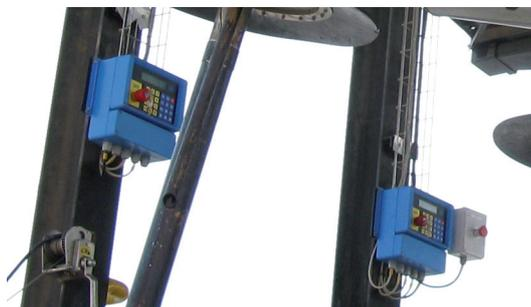
Batching Master zur automatischen Dosierung
