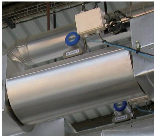
Massedurchfluss-Messgerät mit thermischer Isolation
