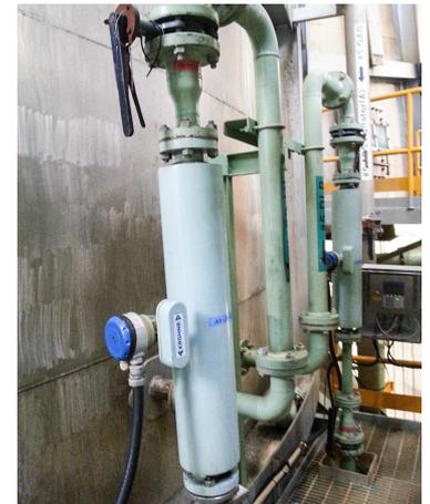
Kalkmilchmessung mit dem OPTIMASS 7400 F
