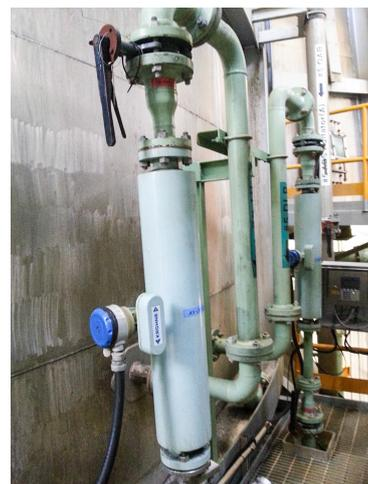
Mesure des boues de chaux avec l'OPTIMASS 7400 F
