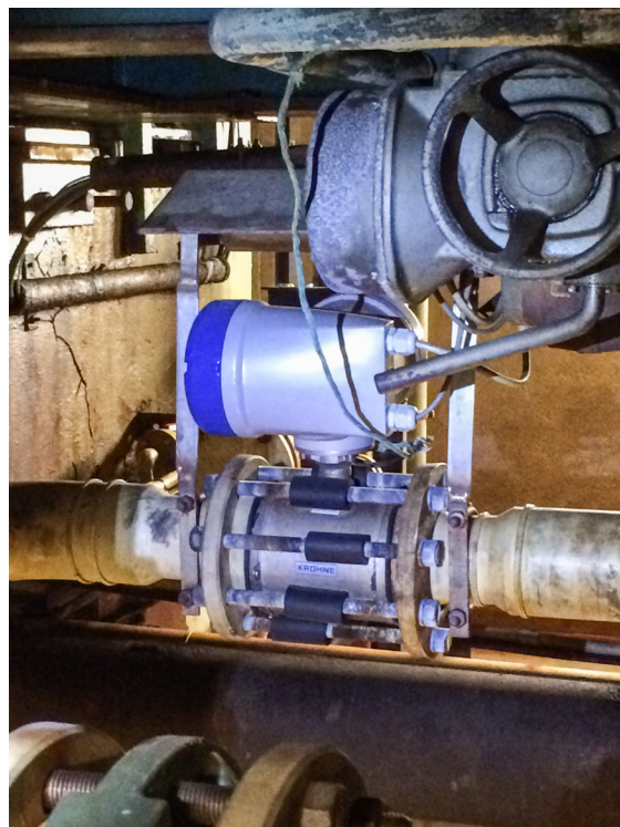
Durchflussmessung von Zinkelektrolyt mit dem magnetisch-induktiven Durchflussmessgerät OPTIFLUX 5300
