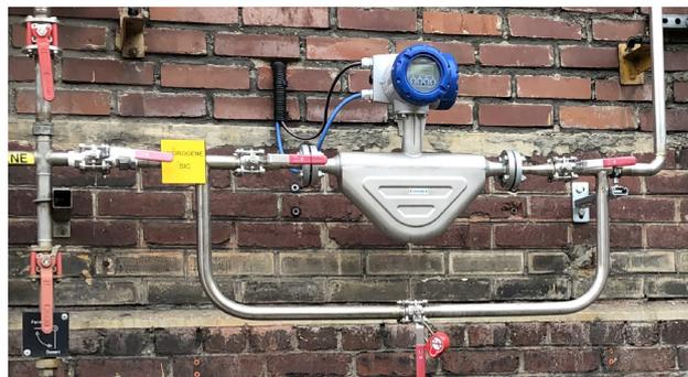
Измерение водорода в компании MERSEN с помощью кориолисового массового расходомера OPTIMASS 6400 (DN10)
