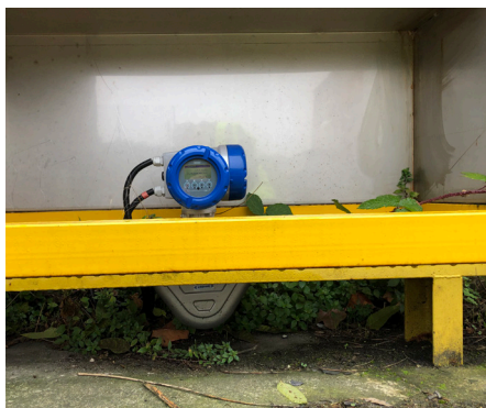
Comptage d'hydrogène général avec le débitmètre massique Coriolis OPTIMASS 6400 S15
