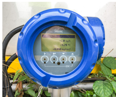
Comptage d'hydrogène général avec le débitmètre massique Coriolis OPTIMASS 6400 S15
