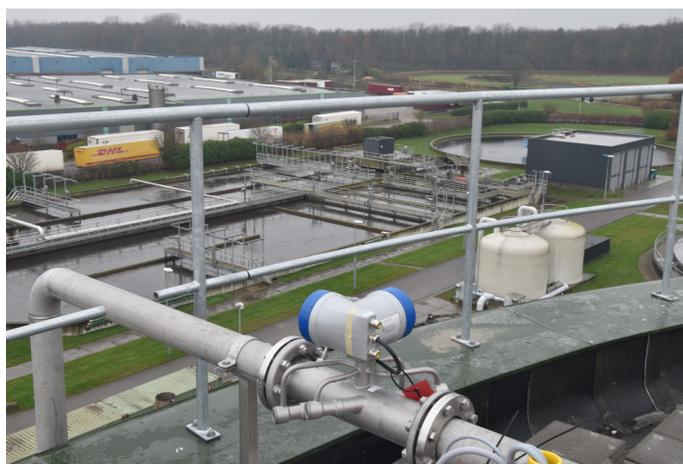
Medida de caudal de biogás detrás del digestor
