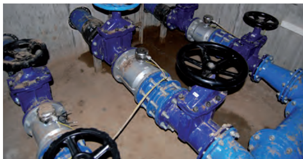
3 compteurs de mesure WATERFLUX 3000 F
