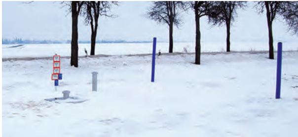
Un puits de distribution très isolé : ce site n'offre aucune possibilité d'alimentation électrique externe pour les appareils de mesure
