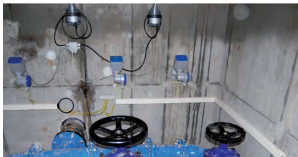
3 convertisseurs de mesure WATERFLUX 070 F et 2 KGA 42
