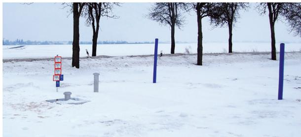
Ein sehr entlegener Verteilerschacht: Hier besteht keine Möglichkeit Messgeräte mit externer Hilfsenergie zu versorgen
