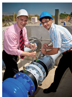
Montage final du compteur
