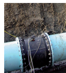
Erdeinbau des Messwertaufnehmers
