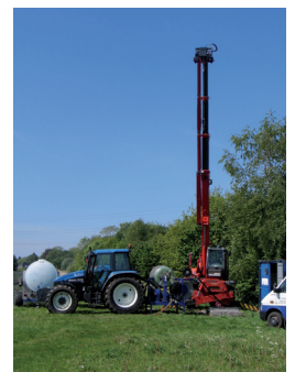
Wartungsskid mit Kran
