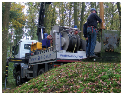
Wartungsskid mit dem WATERFLUX 3070 für die Wartung von Brunnen
