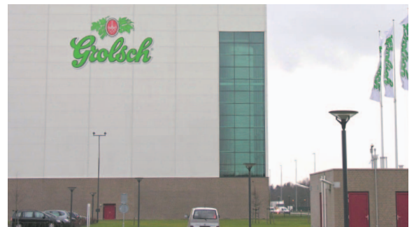
Construction de la brasserie GROLSCH à proximité d'Enschede, Pays-Bas
