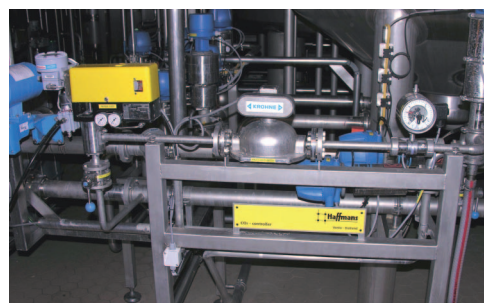
OPTIMASS 7000 F et 3000 F mesurant du dioxyde de carbone gazeux
