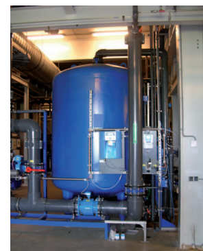
OPTIFLUX 4000 F sur un circuit d'eau
