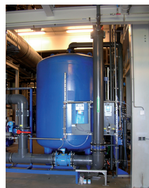
OPTIFLUX 4000 F в водяном контуре
