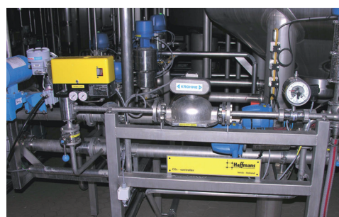
OPTIMASS 7000 F и 3000 F для измерения углекислого газа
