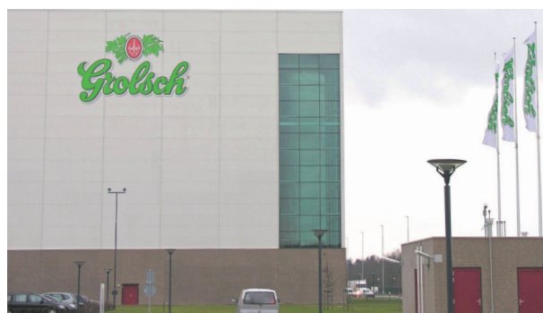
Строительство нового пивоваренного завода GROLSCH возле Энсхеде, Нидерланды
