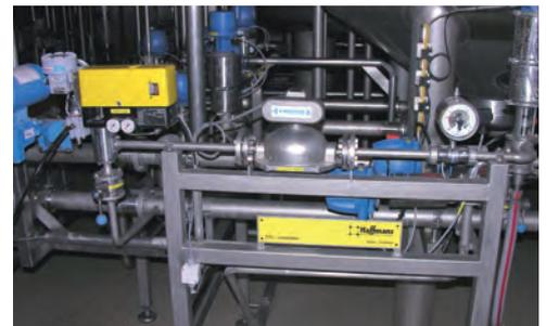
OPTIMASS 7000 F und 3000 F bei der Messung von gasförmigem Kohlendioxid
