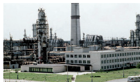
ОАО "Мозырский нефтеперерабатывающий завод"
