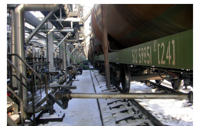
Entladen eines Tankwaggons
