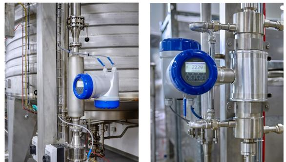
Imagen arriba y a la derecha: OPTIMASS 7400 C con camisa de calefacción; imagen a la izquierda: OPTIMASS 1400 C
