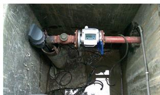
WATERFLUX 3070 C und KGA 42 an verschiedenen Entnahmestellen
