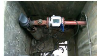
WATERFLUX 3070 C y KGA 42 instalados en lugares diferentes
