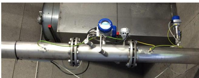
OPTISONIC 7300 Biogas установлен за фильтром
