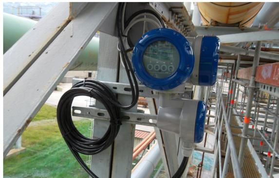
Ultraschall-Durchflussmessgerät OPTISONIC 8300
