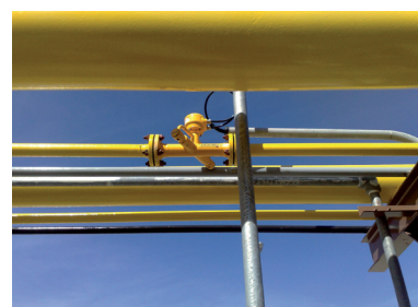
Unidad OPTISONIC 7300 para medir el consumo local de gas natural
