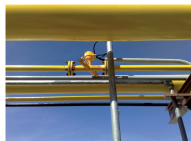
Устройство OPTISONIC 7300 для измерения местного потребления природного газа
