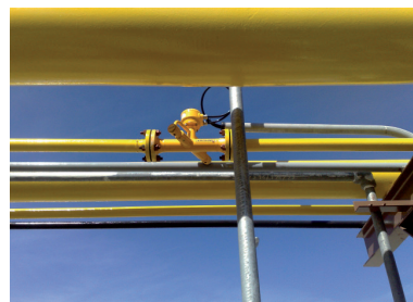
OPTISONIC 7300 Einheit für die Messung des lokalen Verbrauchs von Erdgas
