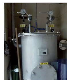
Подвод газа с первым сепаратором воды
