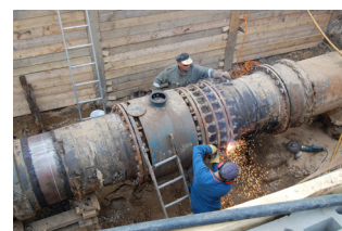
Aufschweißarbeiten am M960 von 1981
