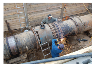
Сварка на M960 1981 год
