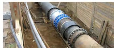
El OPTIFLUX 2300 montado mediante brida con referencia virtual
