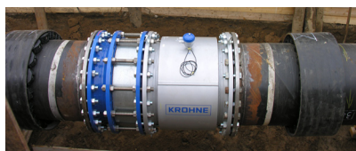
Débitmètre OPTIFLUX 2300 avec référence virtuelle – montage par brides
