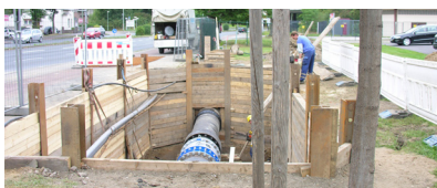
Débitmètre OPTIFLUX 2300 avec référence virtuelle – montage par brides
