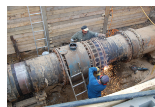
Travaux de soudage sur le M960 de 1981
