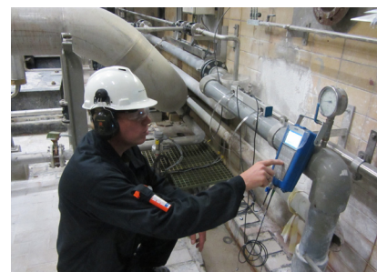
L'OPTISONIC 6300 P avec convertisseur de mesure mobile posé sur une conduite
