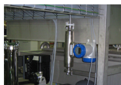
Установка массового расходомера OPTIMASS 1100 C
