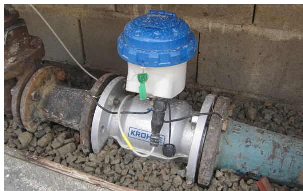
碎石层支撑的测量管
