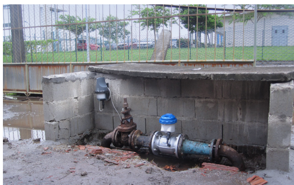
安装在半淹没的区域的 WATERFLUX
