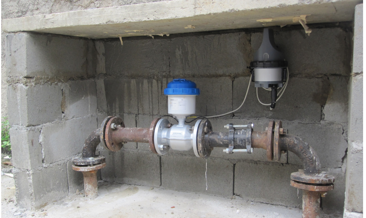
安装于地表管线上的 WATERFLUX, 集成 KGA 42 GPRS 模块
