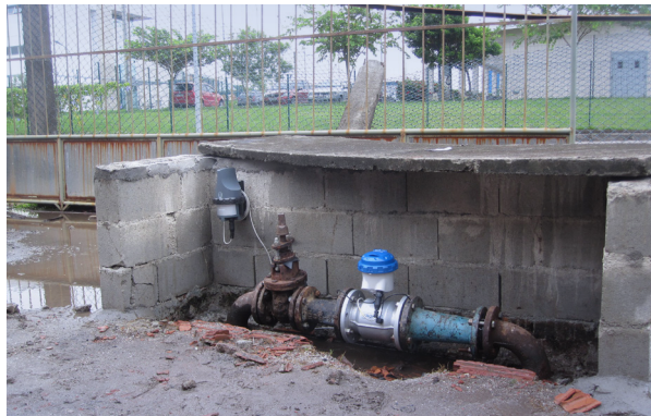
Einsatz des WATERFLUX in teilüberschwemmtem Erdbereich
