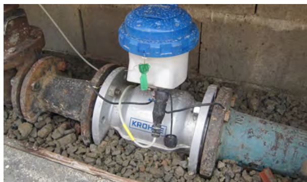
Tubo de medida sostenido por un lecho de grava
