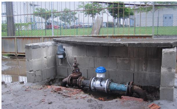
Применение WATERFLUX в условиях частичного затопления
