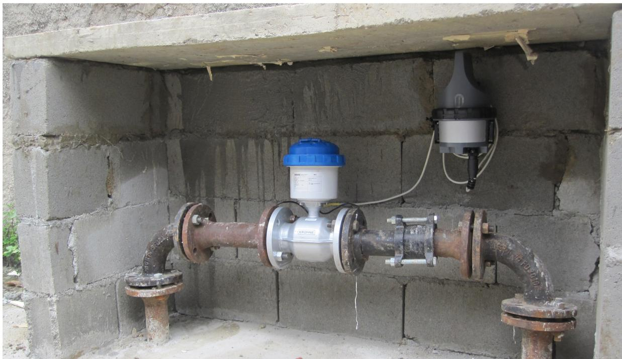
WATERFLUX с GPRS-модулем KGA 42 в наземной части трубопровода
