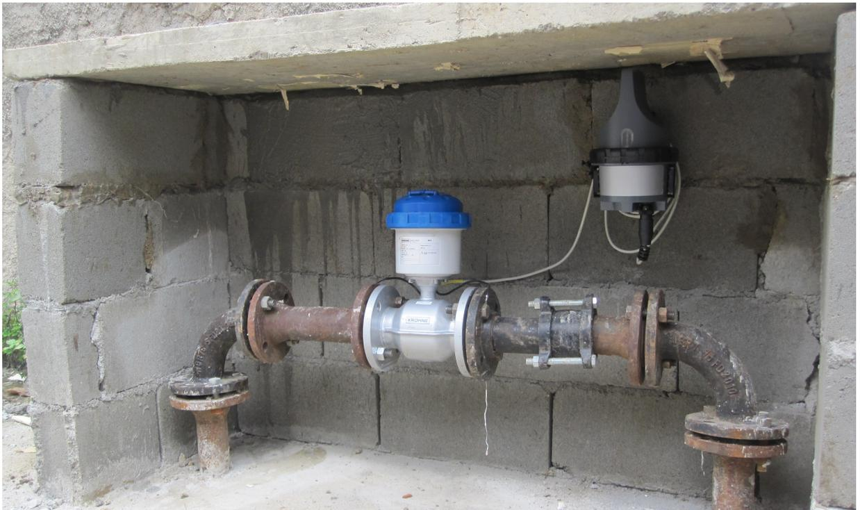
WATERFLUX avec module GPRS KGA 42 dans un tronçon à ciel ouvert de la canalisation
