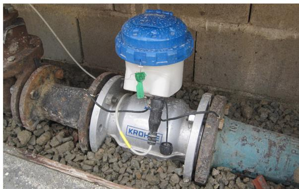
Utilisation du WATERFLUX dans des zones partiellement inondées Tube de mesure soutenu par un lit de gravier
