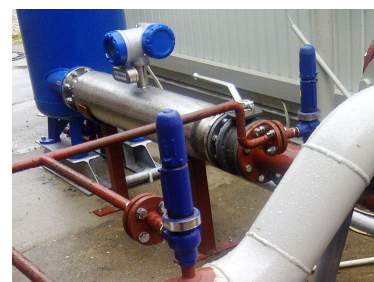
Platzsparende Installation dank Doppelgeradrohr-Design
