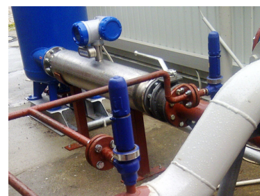
Компактный монтаж благодаря конструкции двойной прямой измерительной трубы
