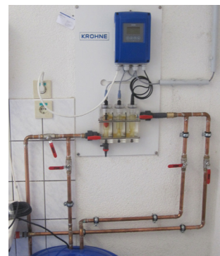
OPTISYS CL 1100 с измерительным и промывочным контуром
