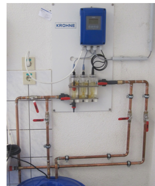
OPTISYS CL 1100 con circuito de medida y lavado
