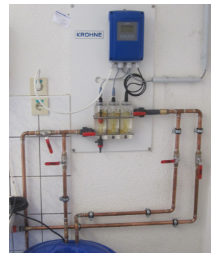
OPTISYS CL 1100 mit Mess- und Spülkreislauf
