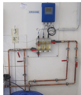
OPTISYS CL 1100 avec circuit de mesure et de rinçage
